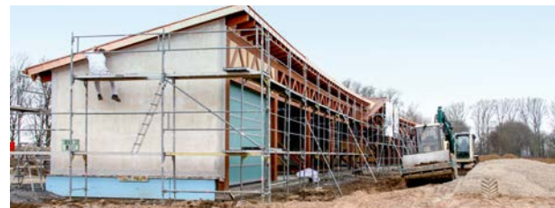
2011–2012 ERWEITERUNG / SPIEGELUNG DER DRIVING RANGE Bau ab Herbst 2011 und Eröffnung am 24.05.2012
