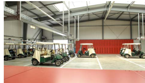
2006–2007 BAU E-CART-HALLE OPELSTRASSE 28 Herbst 2006 bis April 2007
