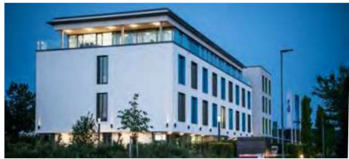
2018–2019 BAU DES ATHLETIC CENTER
