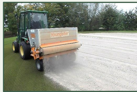
Schritt 3: Ausstreuerung des Sandes auf die Rasenfläche.
